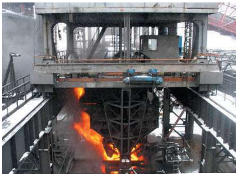
Подъемник УСТК (установки сухого тушения кокса)
