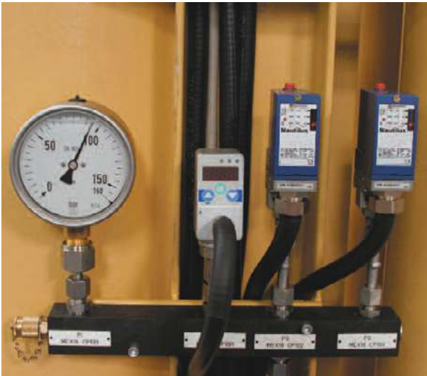
Система контроля давления и положения поршня в аккумуляторе
