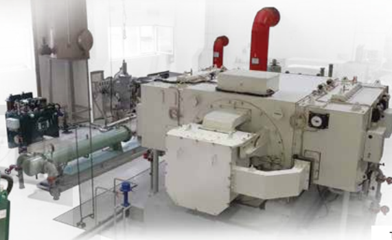
ГИДРАВЛИЧЕСКАЯ СИСТЕМА УПРАВЛЕНИЯ ТУРБИНОЙ НА ТЭЦ
