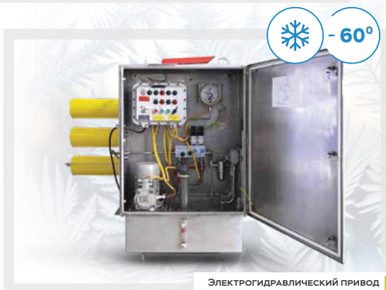
Электрогидравлический привод для трубопроводной арматуры
