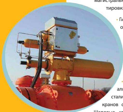
Насосная станция гидропривода шаровых кранов
